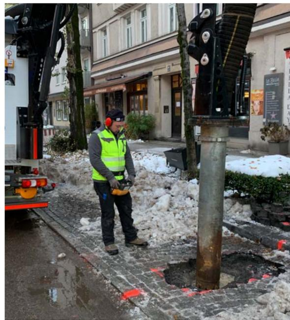
Für die Gewährleistung der Leitungsfreiheit mussten 45 Vorschachtungen durch BauGrund Süd überwiegend in Straßenpflaster und Asphalt vorgenommen werden. Aufgrund der Nähe zu Baumkronen wurde an manchen Stellen zum Wurzelschutz mit speziellen Saugbaggern gearbeitet.
