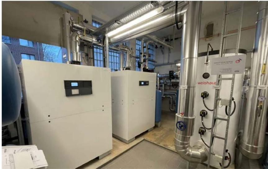
Seit Februar 2024 werden die Bestandsgebäude über zwei Weishaupt Wärmepumpen (WWP S 90 ID) mit Wärme versorgt.
